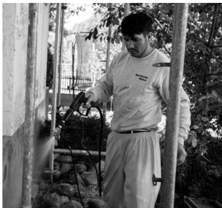
«Wir kennen einander und funktionieren gemeinsam»: Mitarbeitende auf einer Baustelle in Brittnau. (Fotos: adi)
